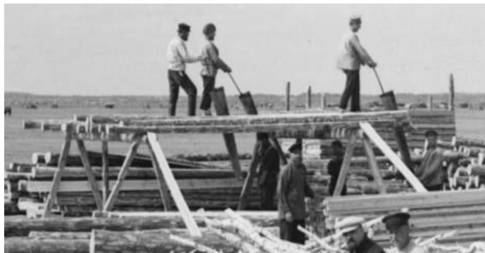
Рис. 1. Распиловка бревен на доски вручную
